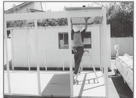
屋根パネルの設置工程
