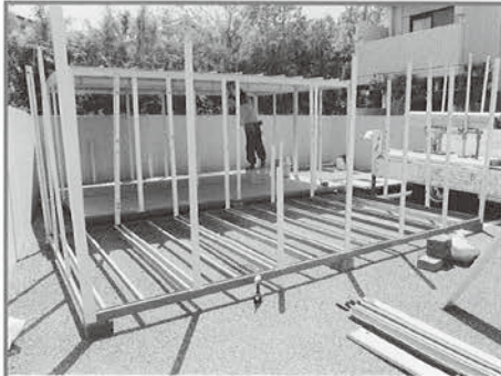
土台・レベル調整後・柱建て上げ
