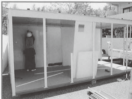
壁パネルの設置
