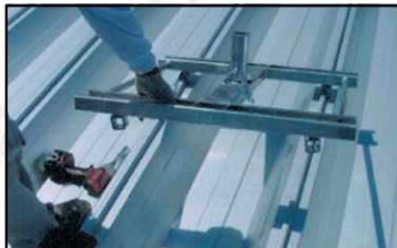
①支柱ベースを仮置きする。その時にハゼ金具をインパクトで緩めておく。
