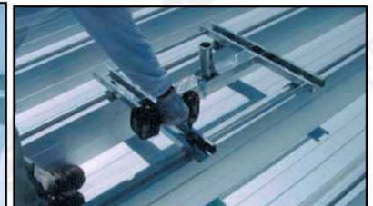
④ハゼ金具のナットをインパクトレンチで締め込み固定する。(ハゼ金具4ヶ所)
