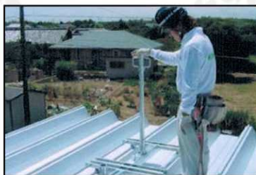
⑥支柱ベースソケット部と支柱の穴にトグルピンで貫通させて固定する。
