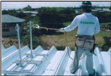
⑦親綱のフックを支柱の取付ピースに掛ける。
