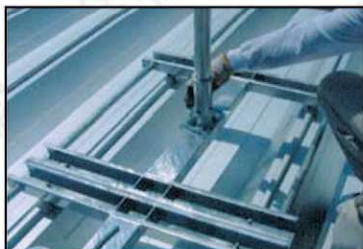
⑤支柱を支柱ベースの中央ソケット部に差し込む。
