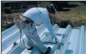
②設置個所は親綱システム用支柱の使用基準に従って計測し位置決める。
