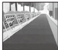
■ 歩行者の仮設通路として
