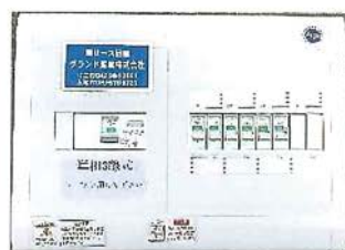
⑥分電盤 40A分電盤 (単相3線式) ※3芯使用
