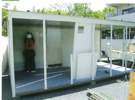
壁パネルの設置
