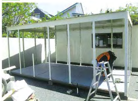
ハウスの枠組み完成
