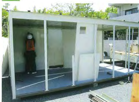
壁パネルの設置
