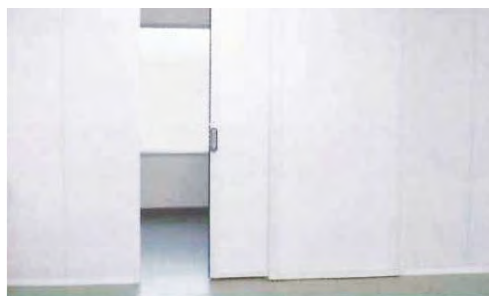
■ パパッとE3パネルでハウス内に扉を設置
