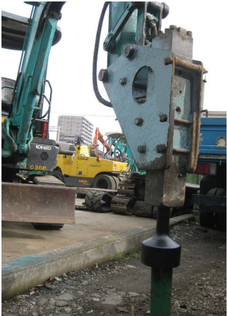
■TNB-3M杭打ちチゼル（0.12共用配管BH） （支柱・木杭・単管パイプ等の打込）
