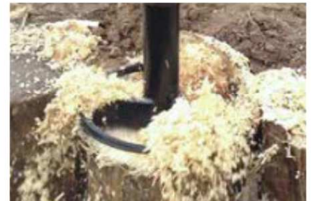
2.油圧ショベルを操作し切削します。
