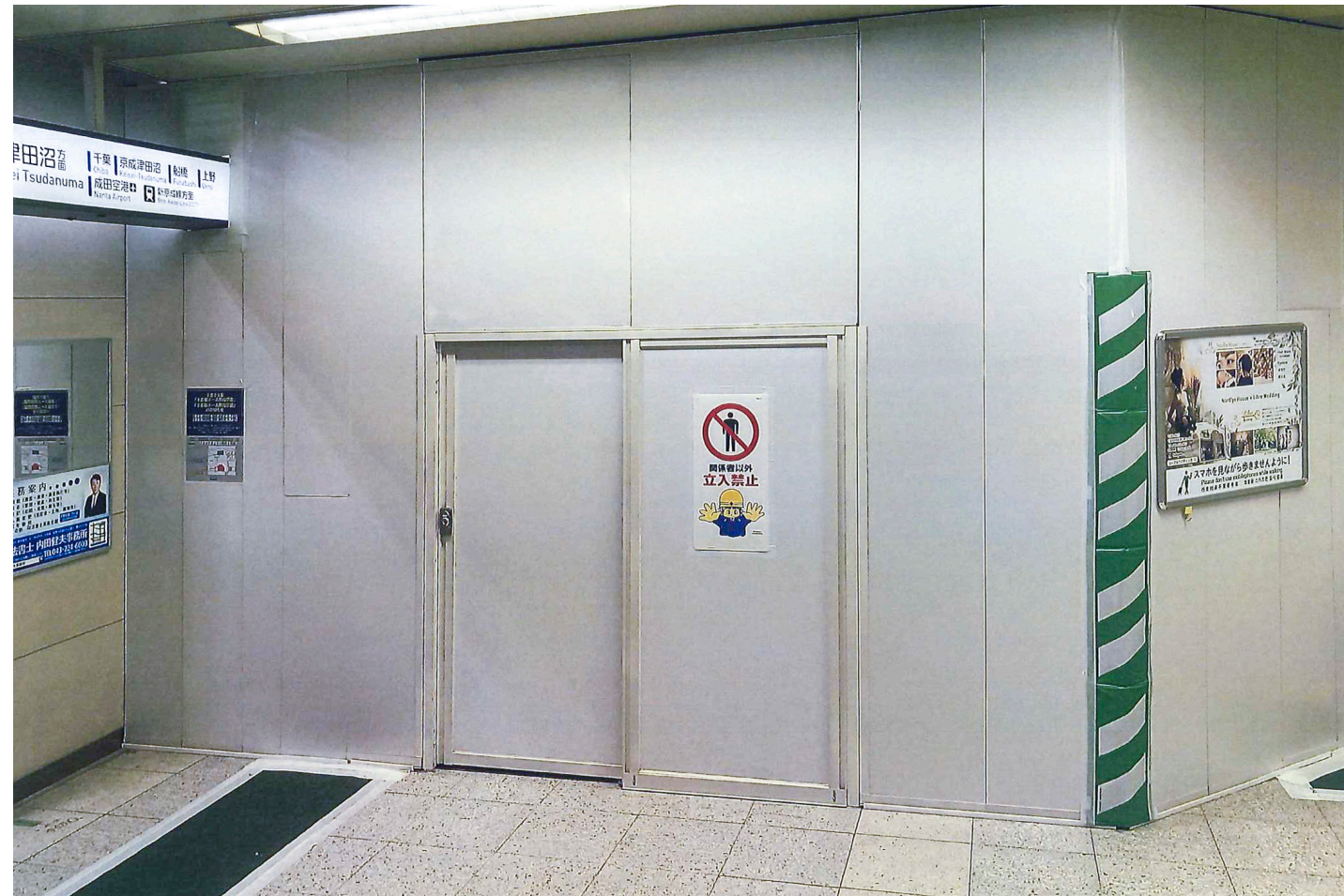
▶ 「仮囲い」として
