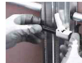
④ 連結金具でパネルを連結
