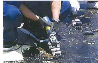
■屋上の防水材はがし
