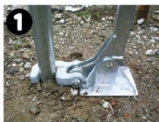
①引き抜き機をパイプにセット
