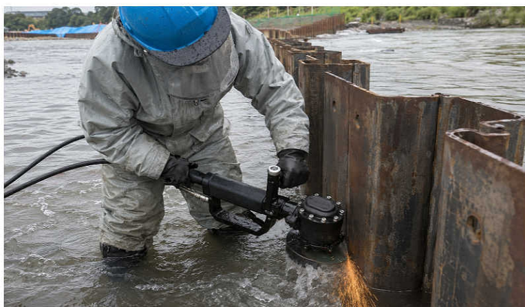
■護岸工事で使用
