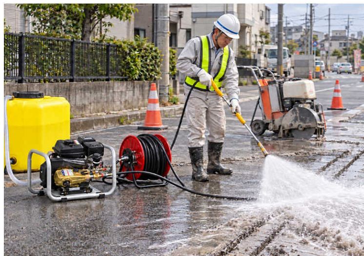
■カッター工事後の道路洗浄に。
